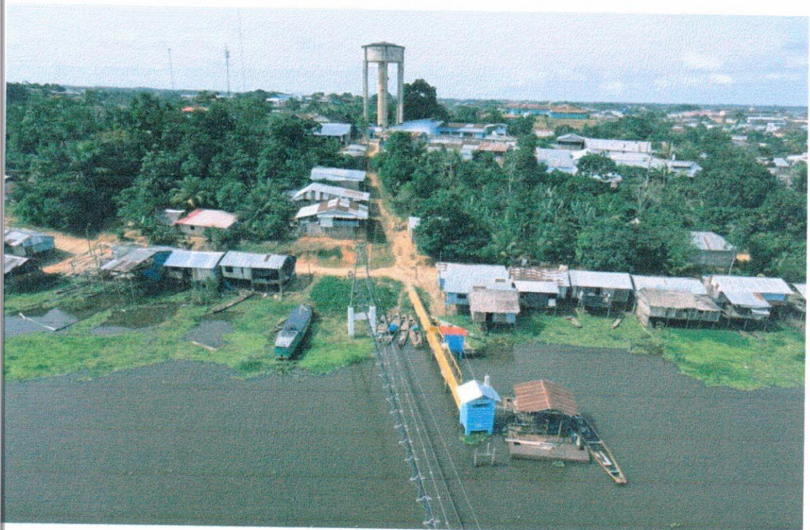
Mejoramiento de Captación en Requena
