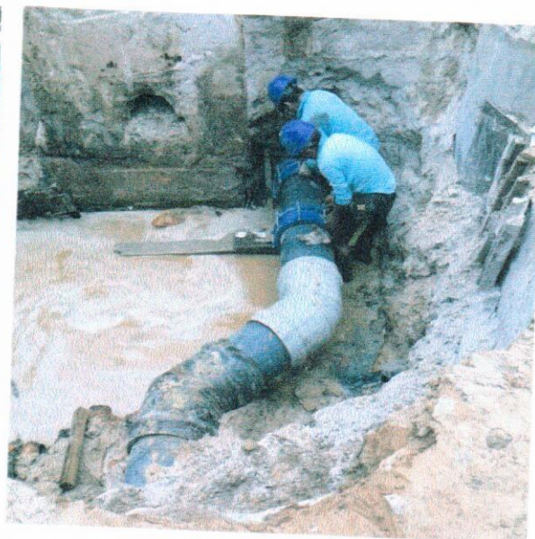
Atención Inmediata en reparación de fugas
