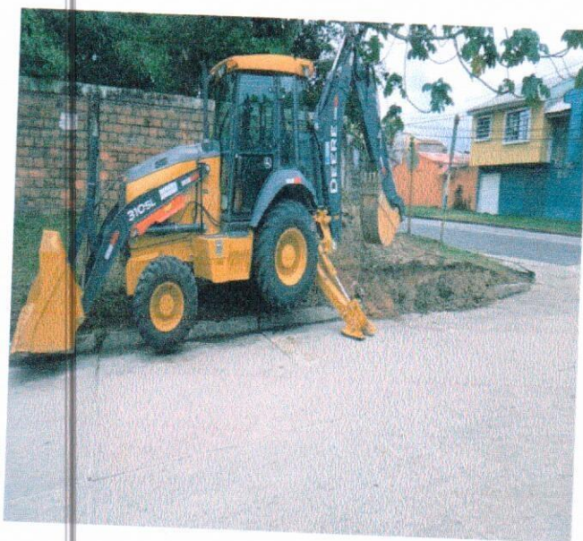
Retroexcavadora en Iquitos
